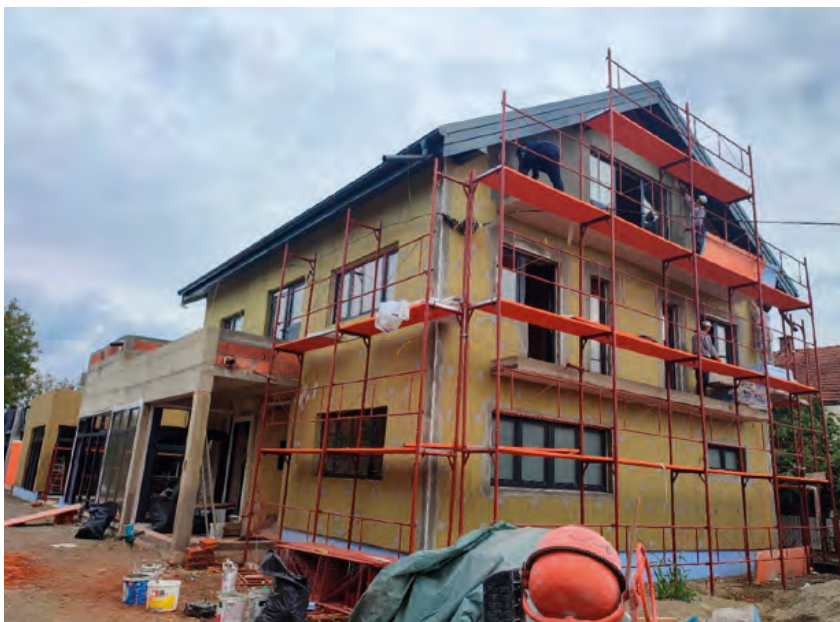
Izgradnja novog Dječjeg vrtića Donji Vidovec
