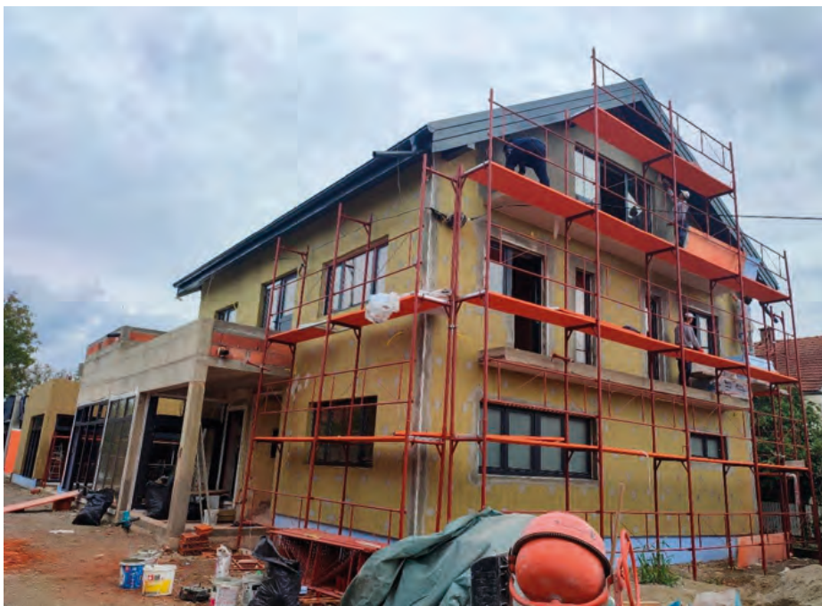
A muravidi új óvoda építése
