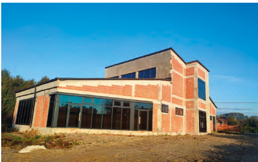
„Drávai arany mosók” látogatóközpont az építkezés kezdeti fázisában
